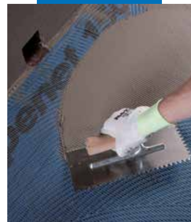
Förstärkning av Mapelastic med Mapenet 150
