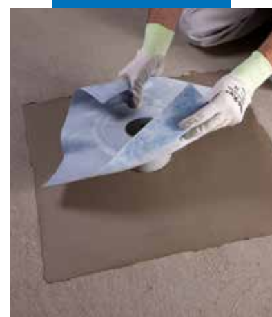
Montering av brunnsmanschett i Mapelastic
