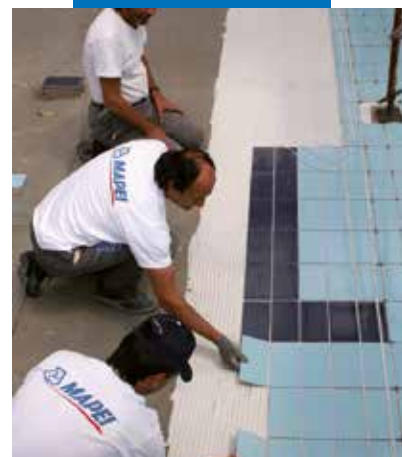
Läggning av keramiska plattor i en simbassäng
