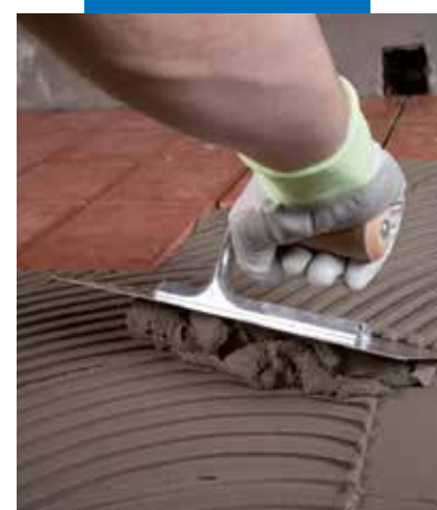
Läggning av keramiska plattor med Granirapid på terrass, vattentätad med Mapelastic
