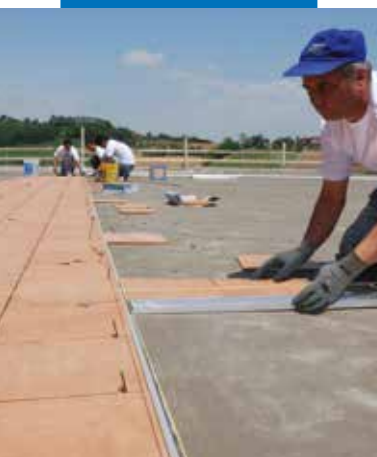
Läggning av keramiska plattor med Kerabond + Isolastic
