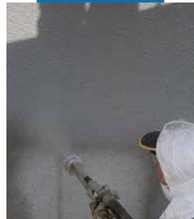
Eksempel på Mapelastic påført på en viadukt ved sprøjtning
