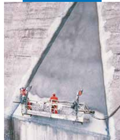
Eksempel på Mapelastic påført på en dæmning ved sprøjtning
