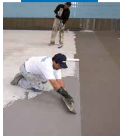
Vandtætning af et svømmebassin med Mapelastic
