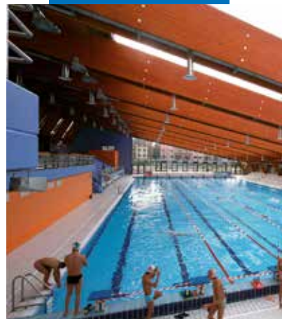
Svømmebassin vandtætnet med Mapelastic: Fritidscentret Scarioni, Milano, Italien
