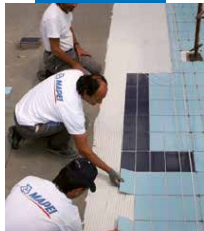
Montering af keramiske fliser på Mapelastic i et svømmebassin
