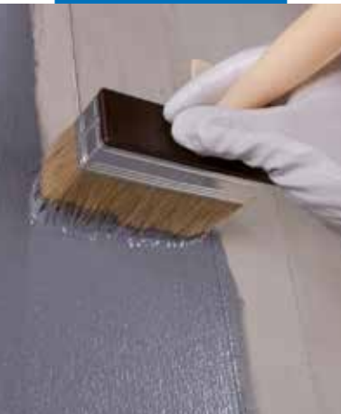
Påføring af Eco Prim Grip på beton med børste
