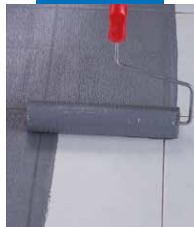
Påføring af Eco Prim Grip med rulle på eksisterende porcelænsfliser
