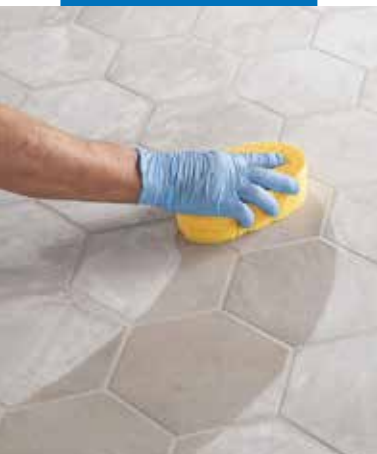
Rengjøring og sluttbehandling av fuger med en hard cellulosesvamp
